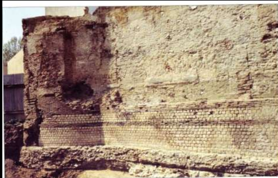
FIG. 59. TOUR ET COURÈNE DE L'ENCEINTE À L'ANCIEN HÔPITAL LARREY. Cliché R. De Filippo.
