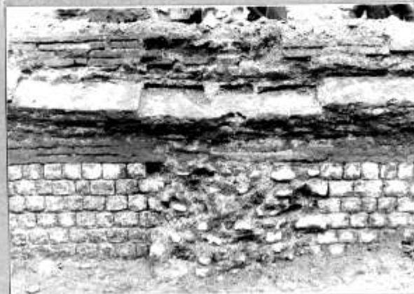
Photo 38 : Tour Ouest, face intérieure côté Est. Détail de l'arrachement du mur transversal. A la base de ce mur, côté gauche on voit le retour du parement de moellons. La hauteur, peu importante, est fonction de celle des premières rangées de moellons.
