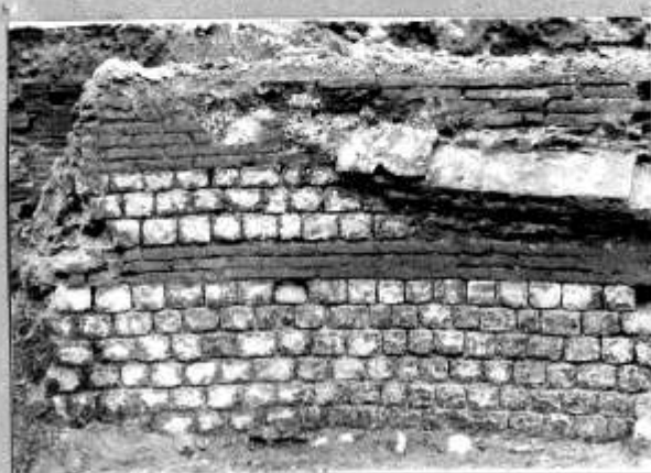
Photo 36 : Tour Ouest, face intérieure côté Est. Détail du parement de l'arrondi. De bas en haut, on compte 6 rangées de moellons, 3 assises de briques, 3 rangées de moellons, puis de nouveau 9 assises de briques.
