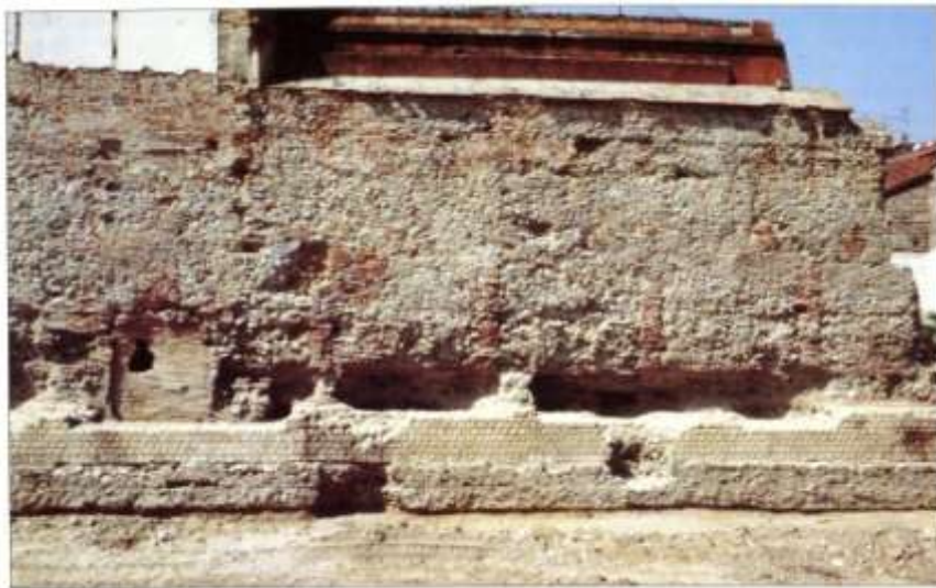
FIG. 60. COURSE DE L'ENCENTE À L'ANCIEN HÔPITAL LABREY : l'enlèvement des briques de parement laisse voir les maçonneries transversales du blocage. Clément R. De Filippo.
