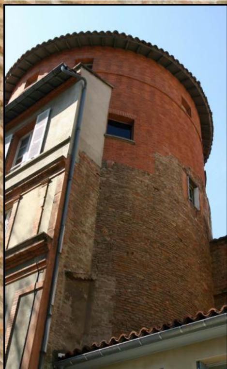
Ci-dessus : tour romaine réhabilitée rue Jules Ressayguier.
