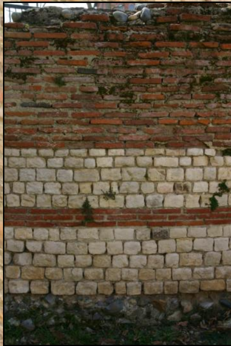
Parement extérieur Rue Bida (Photo Ch. Camps)
